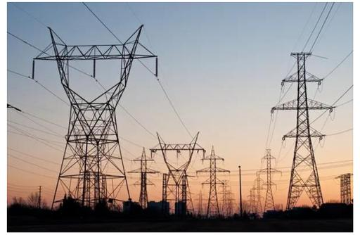
Luego, cuando la corriente llega a un pueblo o ciudad, las subestaciones transformadoras disminuyen el alto voltaje para viajar por el circuito de voltaje medio. Así, la energía podrá transportarse sin problemas por tu barrio a través de cables elevados o cables subterráneos.
